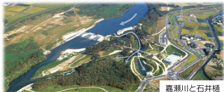
筑後川と山田堰
